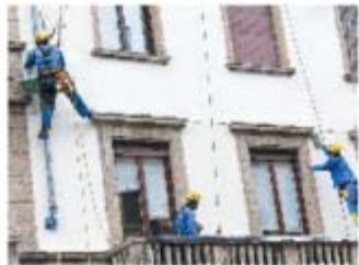
Operai al lavoro in un cantiere
